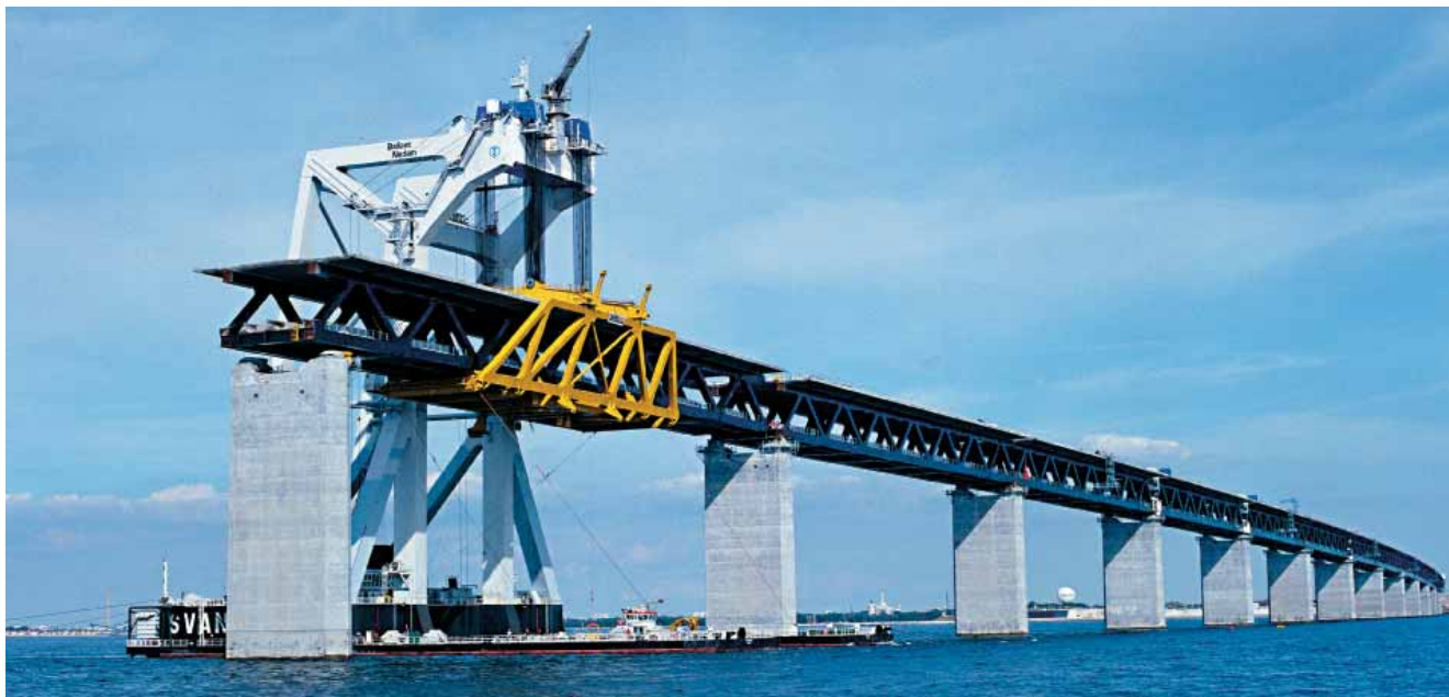
Montage af tilslutningsfag for overbygningen, Øresundsforbindelsen
