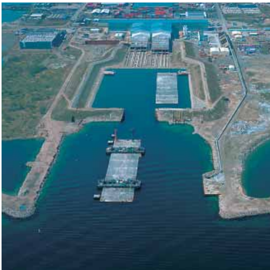
Tunnelementfabrik, Københavns Nordhavn, Øresundsforbindelsen
