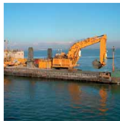
Eksempel på mekanisk gravemaskine (back hoe)
