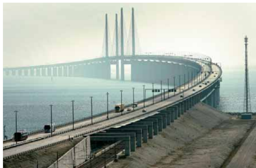
Illustration af viadukten, der muliggør overgangen fra to-etages broen til rampeområdet på land, Peberholm, Øresundsbron
