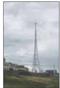
Radiomast, Kalundborg langbølgesender.
