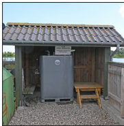
Den nye tank.
