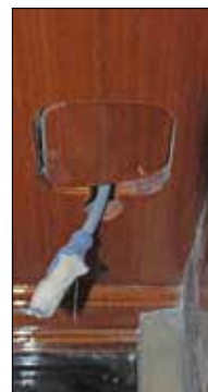
Strøm til mastens lanterner.
