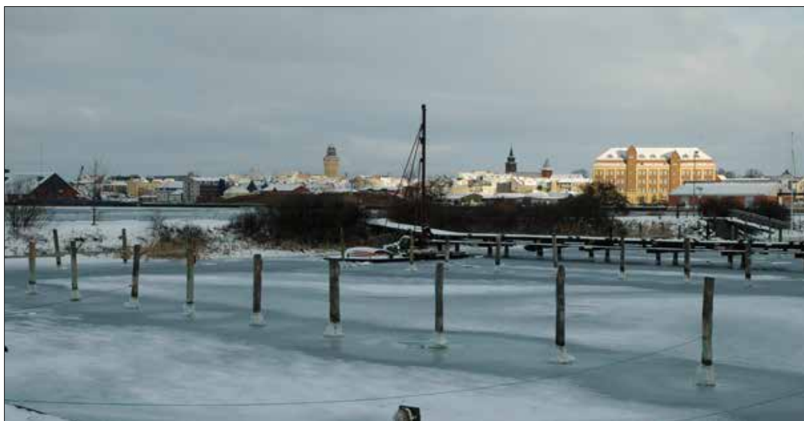
Isen kan true med at trække pælene op. Foto: Palle Tørnqvist
